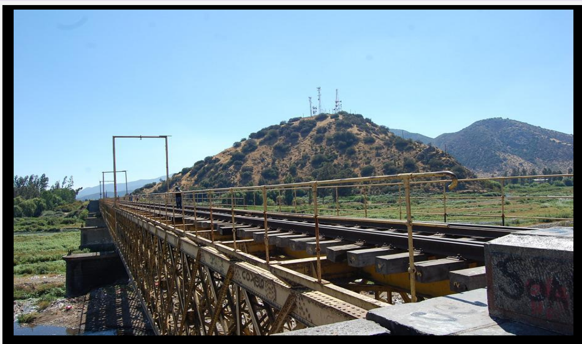
Vista de los alrededores de Talagante
